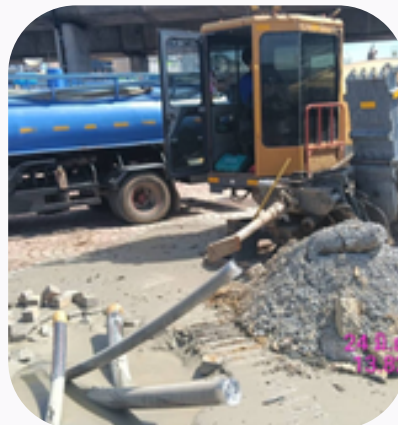
งานดินลอดท่อร้อยสายไฟรมทางหลวง พระราม5 บริษัท ฟิสิษฐ์ เอ็นจิเนียริง (159) จำกัด
