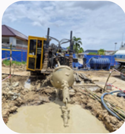
งานเดินลอดท่อสายไฟฟ้าลงใต้ดิน การไฟฟ้าเพชรบุรี บริษัท พงศกร ก่อสร้าง จำกัด
