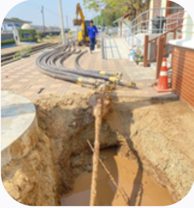
งานดินลอดท่อสายสื่อสาร การรถไฟ ปากน้ำโพ บริษัท ยูนิค เอ็นจิเนียริง แอนด์ คอนสตรัคชั่น จำกัด
