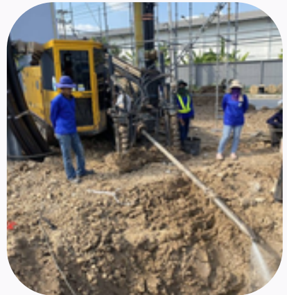
งานดินลอดท่อพร้อมติดตั้งบ่อพักสายไฟแรงสูง บริษัท วี-โปร เอ็นจิเนียริง แอนด์ คอนสตรัคชั่น จำกัด
