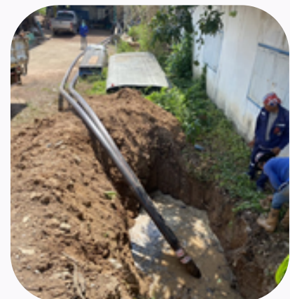
งานเดินลอดท่อสายไฟฟ้าลงใต้ดิน การไฟฟ้าปทุมธานี บริษัท พีเอ็ม คอนสตรัคชั่น เอ็นจิเนียริ่ง แอนด์ ดีเวลอปเม้นต์ จำกัด
