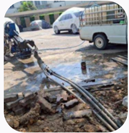
งานเดินลอดท่อร้อยสื่อสาร พร้อมติดตั้งบ่อพัก บริษัท นวัตกรรมไฮดรอลิคฟอร์แมชั่น จำกัด
