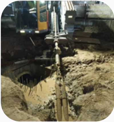
งานเดินลอดท่อสายสื่อสาร การรถไฟ พระราม3 บริษัท ยูนิค เอ็นจิเนียริ่ง แอนด์ คอนสตรัคชั่น จำกัด
