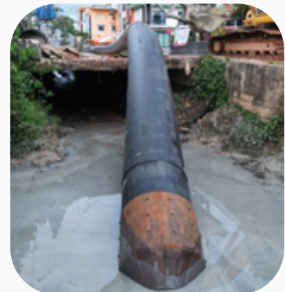
งานดินลอดระบบรวบรวมน้ำเสีย เทศบาลนครหาดใหญ่ บริษัท ไทยดีลเลอร์ไฟฟ้า จำกัด
