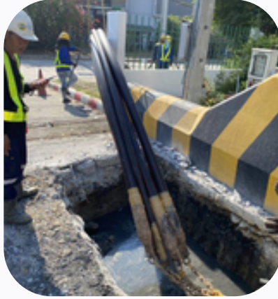
งานดินลอดท่อพร้อมติดตั้งบ่อพักสายไฟแรงสูง บริษัท ไอเรียนเทิลคอปเปอร์ จำกัด
