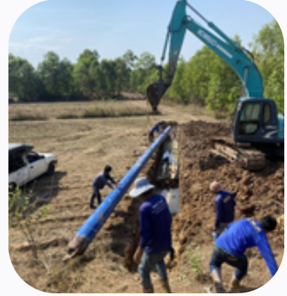
งานดินลอดท่อส่งน้ำชลประทาน สระบุรี บริษัท สยามมิตร คอนเน็คท์ จำกัด
